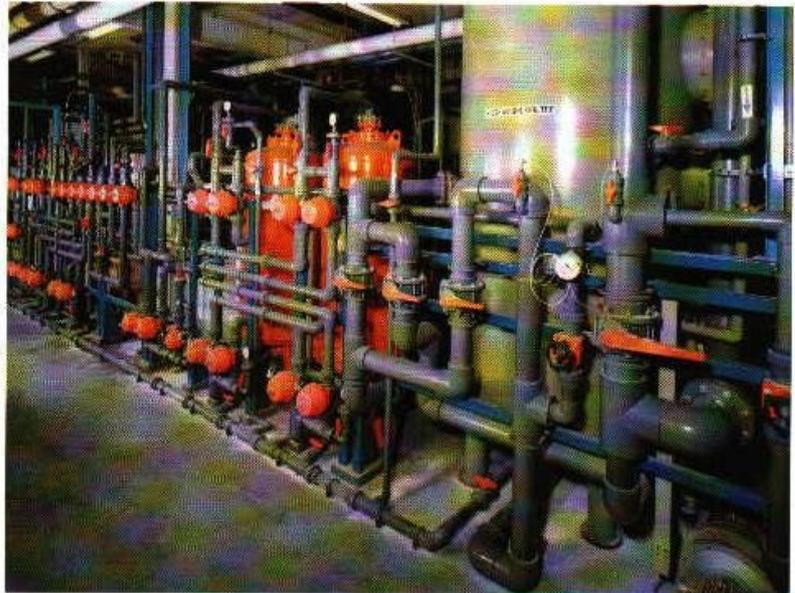
bar. Daher ist bei Eloxalabwasser eine zweistufige Neutralisation pH 4-5 und dann auf pH 7-8 angebracht, wobei sich eine gut absetzbare Flocke bildet.
