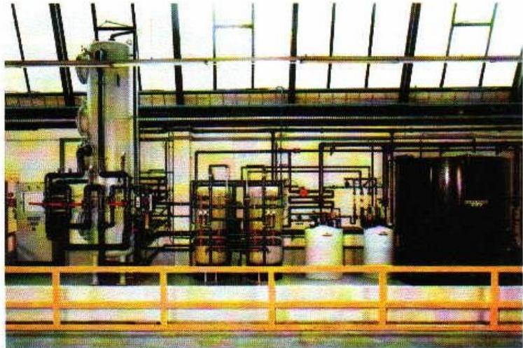
Die Selektivtauscher arbeiten nur im neutralen Bereich optimal. Eine pH-Korrektur mit HCl im Einlauf wird deshalb durchgeführt. Der frisch regenerierte Selektivtauscher, Regeneration mit HCl (2 Bettvolumen 8%ig), Konditionierung mit NaOH
